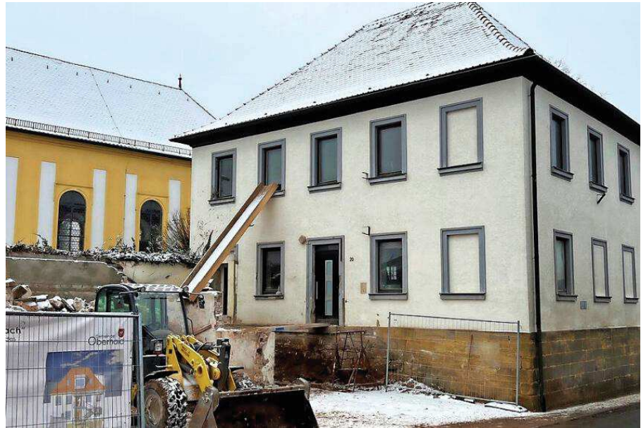
Die Bauarbeiten an der Alten Schule in Staffelbach haben begonnen. Hier sollen drei moderne Wohnungen in alten Gemäuern entstehen.
