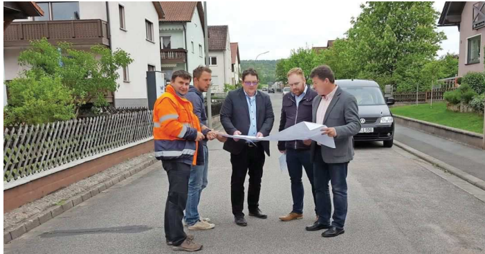
Bürgermeister Carsten Joneitis (rechts) nimmt mit Vertretern der Weyrauther Ingenieurgesellschaft und der Baufirma Einsicht in die Sanierungspläne der Hirtenstraße.
