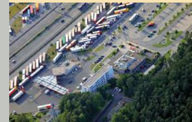
A 9 Tank- und Rastanlage Feucht
