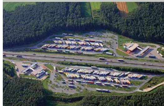
A 6 Tank- und Rastanlage Kammersteiner Land
