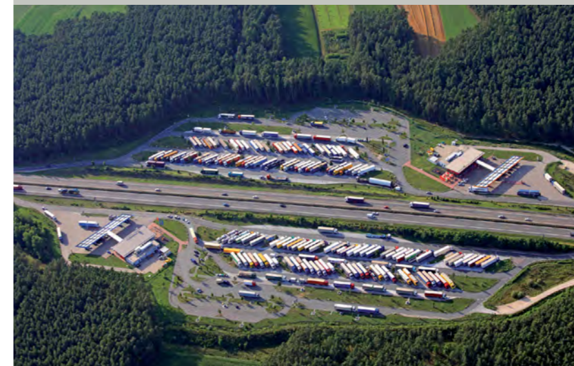
A 6 Tank- und Rastanlage Kammersteiner Land
