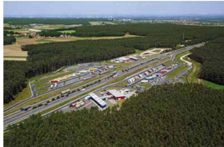
A 6 Tank- und Rastanlage Kammersteiner Land
